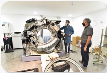
Instalación de equipos emisores de rayos X
