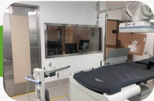
Blindaje de salas con láminas de plomo
