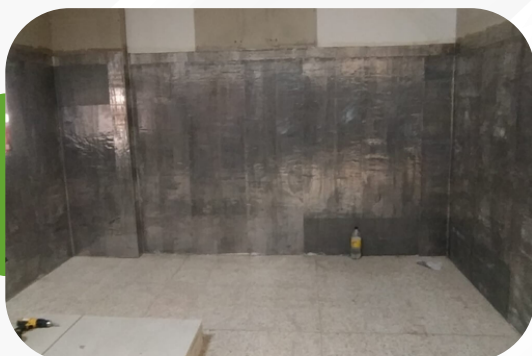
Instalación de puertas y vidrios plomados
